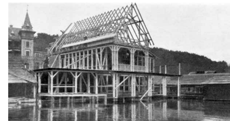
Baustelle 1908 Holzskelettbau, Sammlung Aichinger
