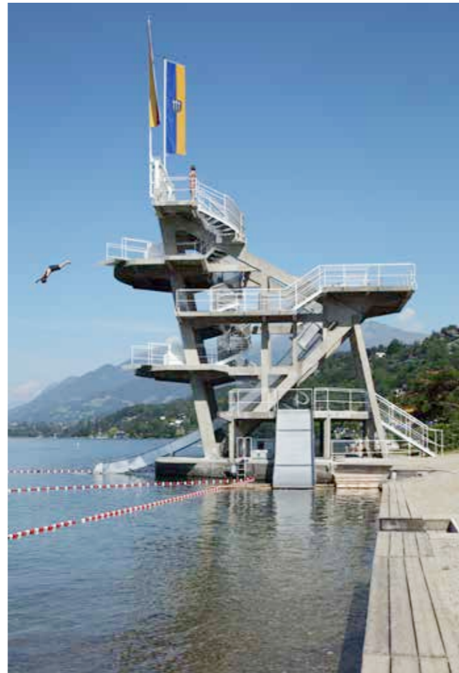
Sprungturm Millstatt (c) Christian Brandstätter
